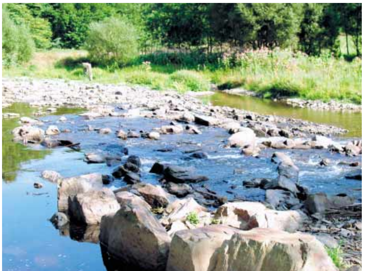
Rückbau des Kalborner Wehres im Rahmen des Interreg II Programms
