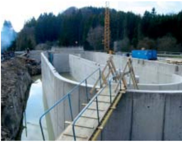
Baustelle der Kläranlage
