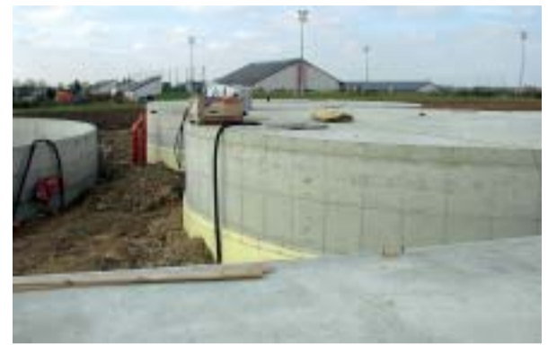
Baustelle der Biogasanlage in Reuler
